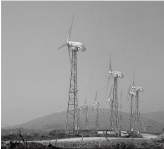
En la central eólica de Tarifa (Cádiz) se aprovecha la fuerza del viento para la producción de energía.
